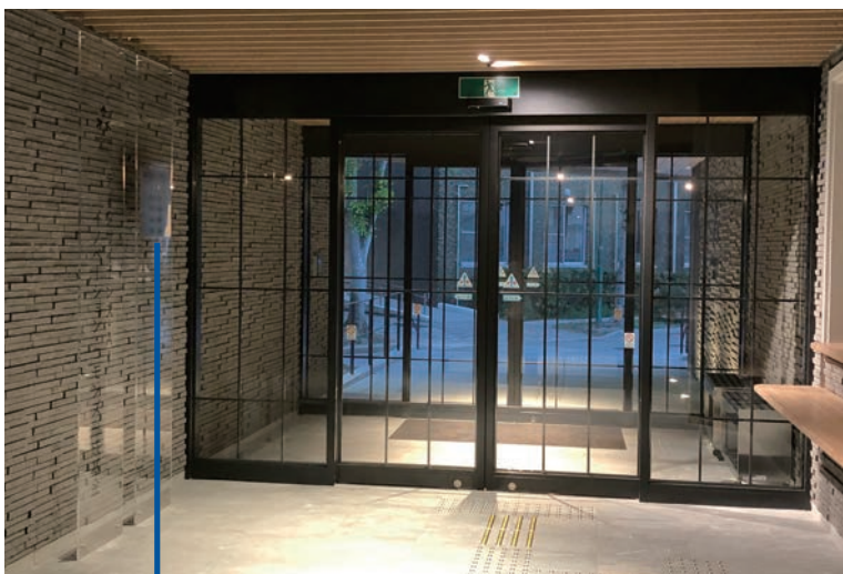
イニシアティブ棟 エントランス
