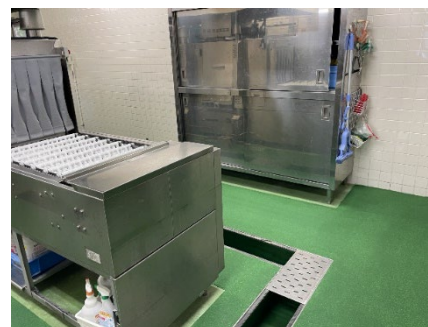
(膳所) 給食調理室床等改修
