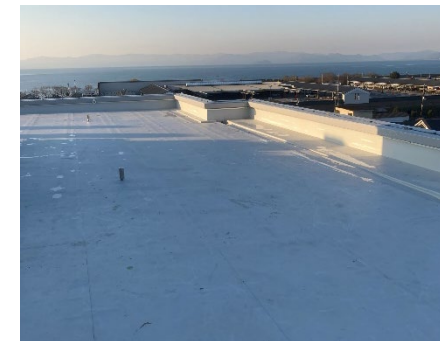
(彦根) 第2校舎棟外壁等改修 [防水]
