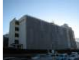
(石山) 人文・社会・教育棟等空調設備改修工事(工事中)
