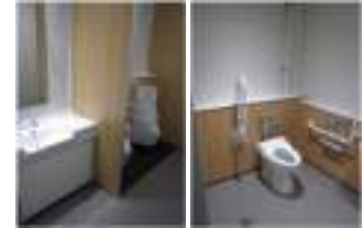
(石山) 美術・技術職業棟トイレ改修工事
