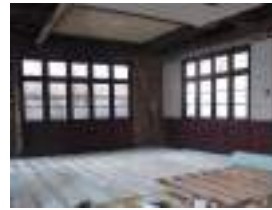
(彦根) 陵水会館改修工事(工事中)
