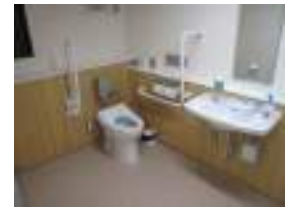
(石山) 附属図書館分館多目的トイレ改修工事
