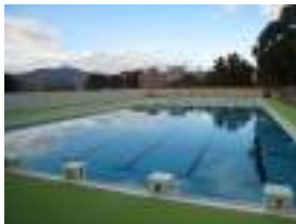
(膳所) 附属学校プール改修工事
