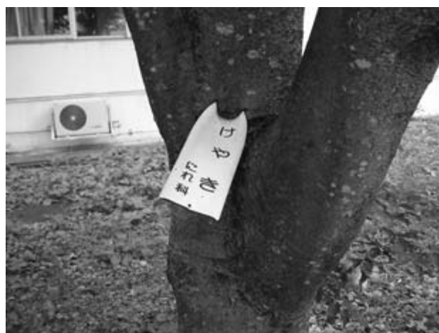
写真1 プレートがめりこんだケヤキ
