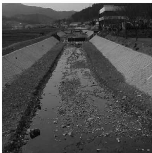
図6 直降下コンクリート護岸および洪水時浮遊ゴミ流入
