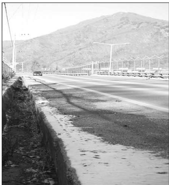
図5 道路上の初期雨水の河川への流入および橋梁路面排水の河川流入
