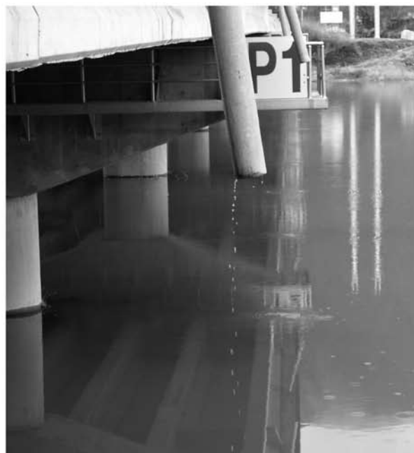
図5 道路上の初期雨水の河川への流入および橋梁路面排水の河川流入
