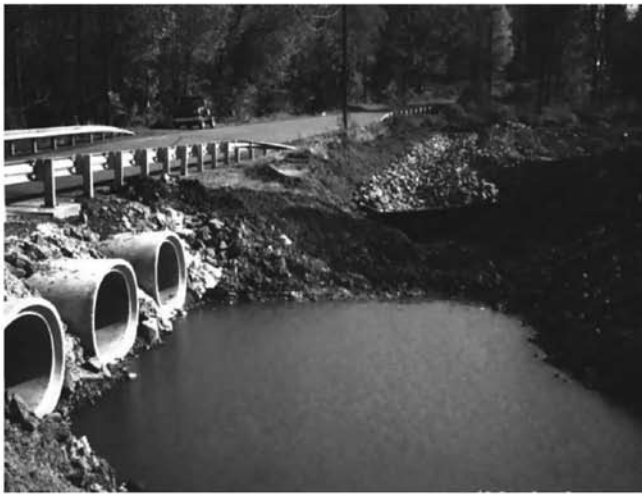
図7 重金属を含む坑内水の流出
