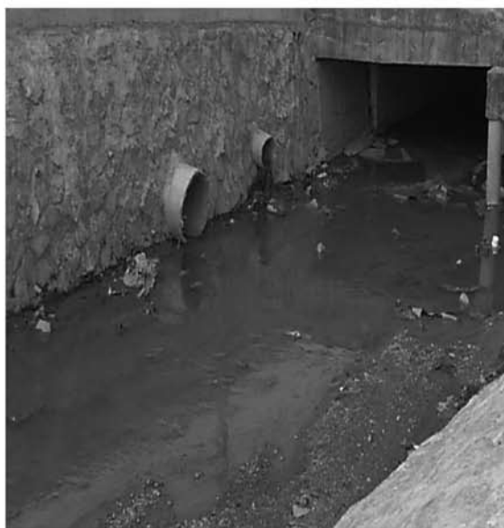
図2 降雨時の初期溢流水 (CSOs) の流出
