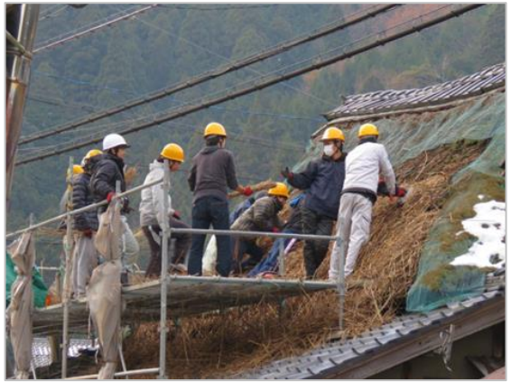
栗栖の西村商店 茅葺屋根修理(12月)
