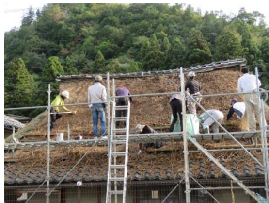
栗栖の西村商店 茅葺屋根修理(10月)
